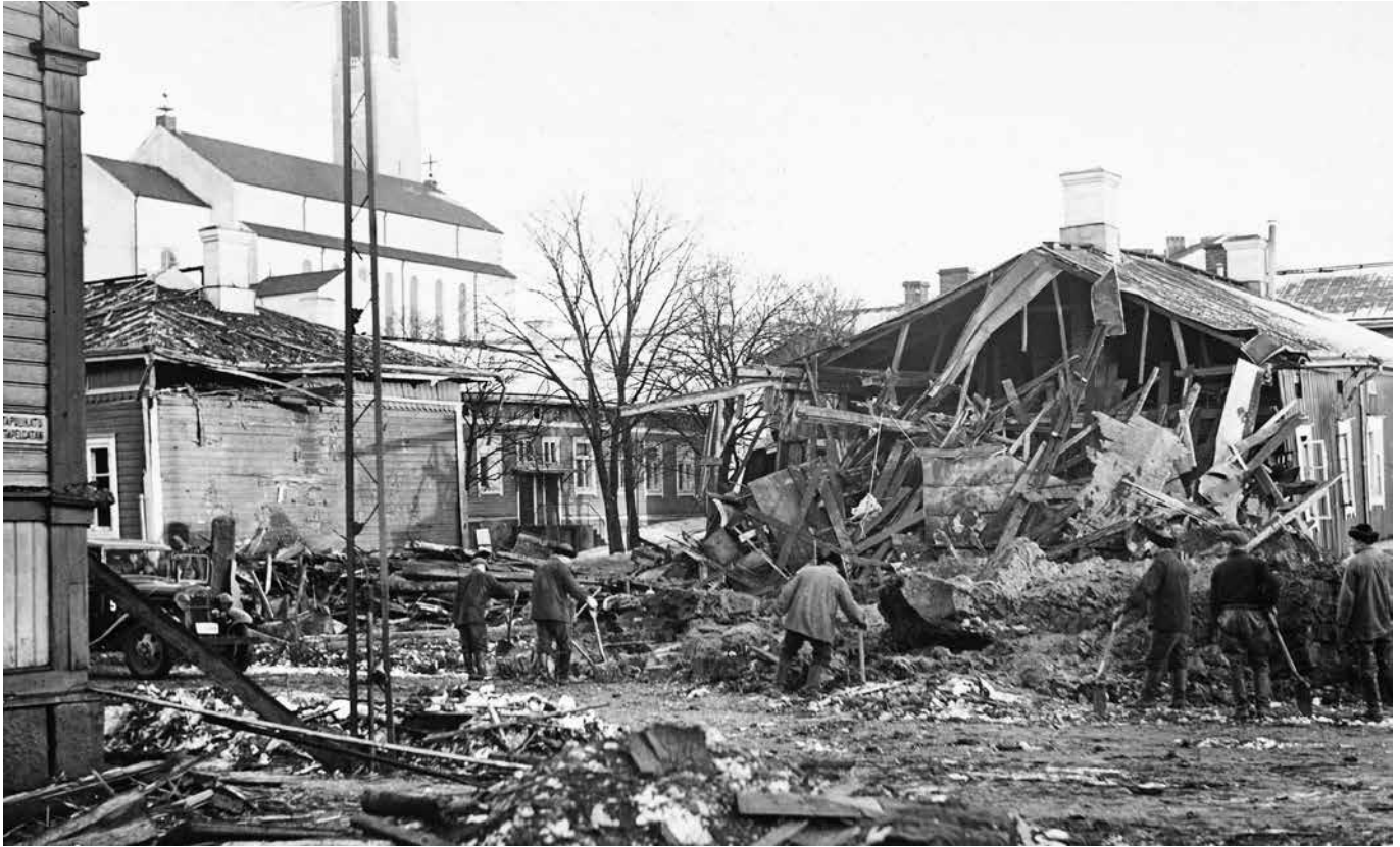
Pommituksessa vaurioituneita puutaloja kuvattuna Tiilentekijäntien ja Tapulikatun risteyksessä. Kuvan oikeassa laidassa on puutalo, jonka päätyseinä on sortunut. Vasemmalla laidassa on puutalo, jonka seinässä on kiinni Tapulikatun kyltti. Taaempaa kuvassa vasemmalla näkyy auto, lisää puutaloja ja Martin kirkko. Rakennusten edustalla on sortuneita rakenteita kasoittain. Oikeanpuoleisen talon edustalla seisoskelee ja työskentelee miehiä lapoiden kanssa. Turun museokeskus. Kuva Yrjö Paldan.
