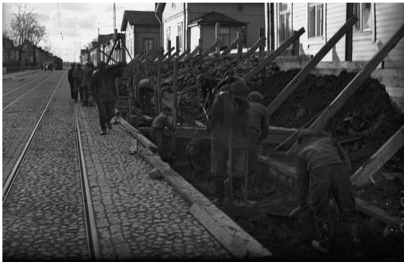
Vesijohtotyömaa Itäisellä Pitkälläkadulla Kivenhakkaajankadun ja Sepänekadun välissä. Julkaistu Turun Sanomissa 14.11.1939/Turun museokeskus.
