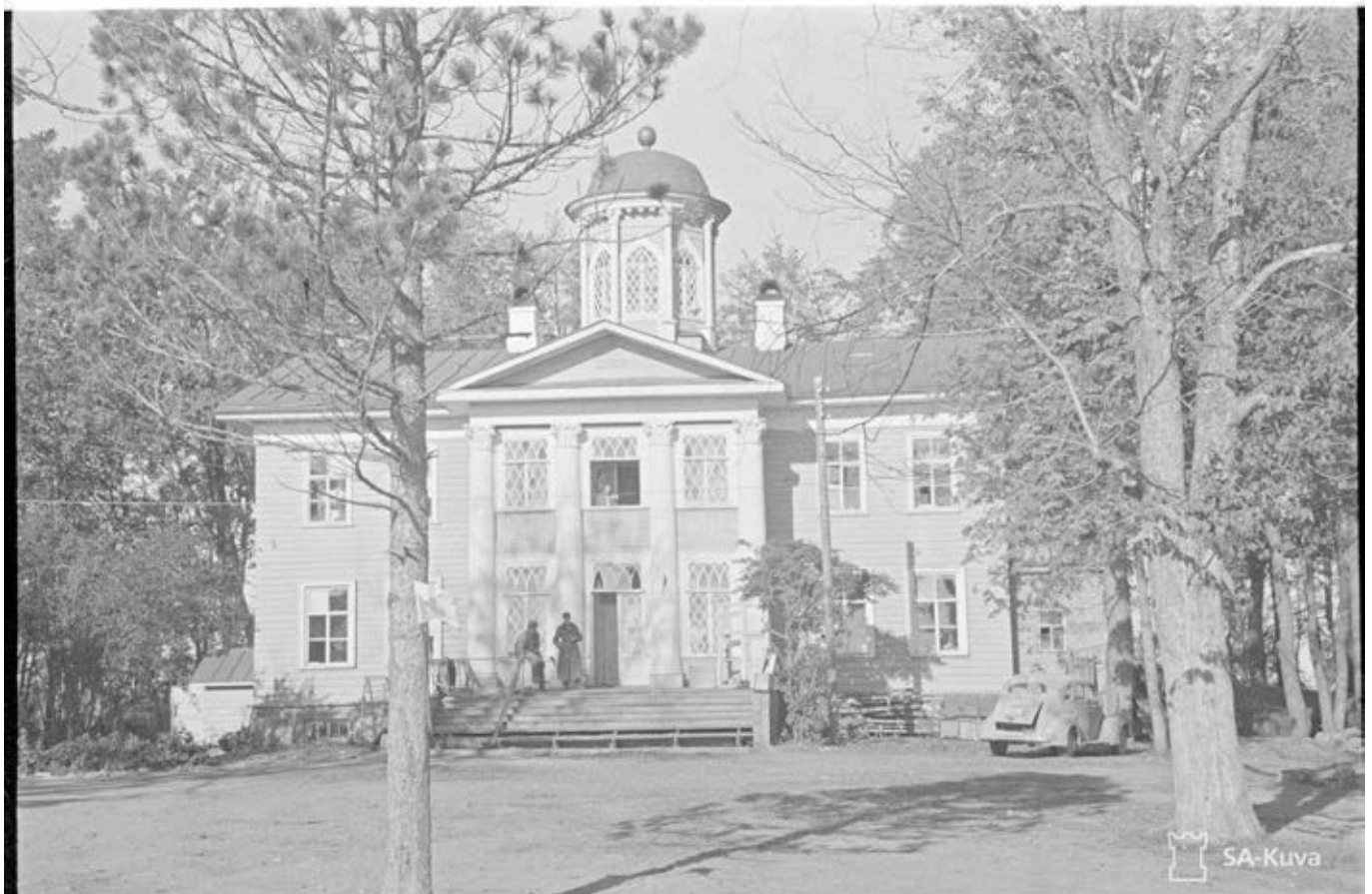
Kuusaanhovin päärakennus. Muolaa 27.8.1941.
